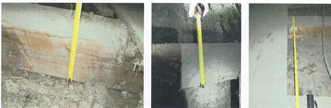
Foto nr. 53 a, b– Aspect sondaje elemente grinzi planșeu din lemn
