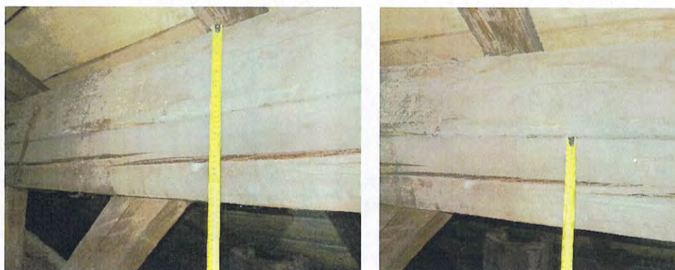
Foto nr. 54 a, b– Aspect sondaje elemente șarpantă – grindă compusă
