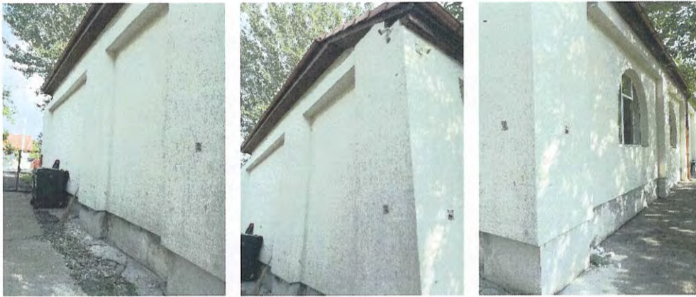
Foto nr. 4 a, b, c – Aspecte consolidări fațade
