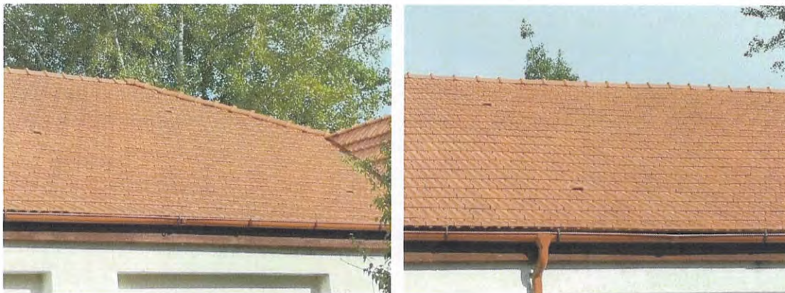
Foto nr. 7 a, b – Aspecte învelitoare
