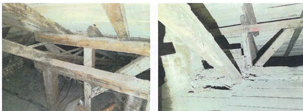
Foto nr. 36 a, b – Aspecte elemente – șarpantă
