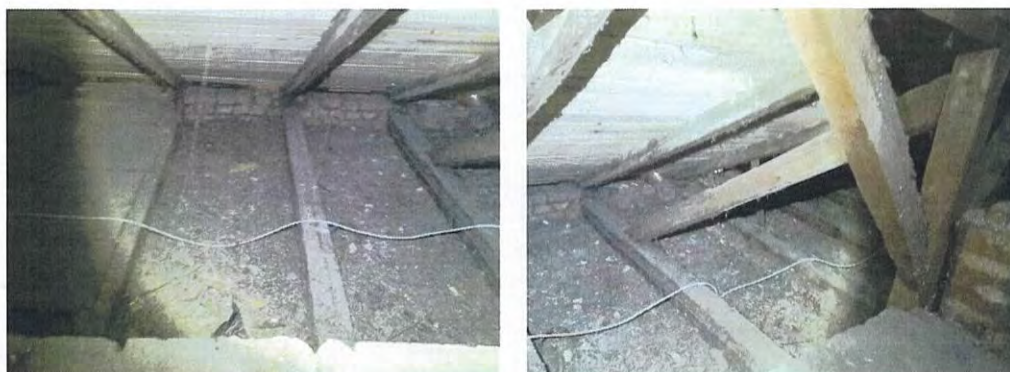
Foto nr. 35 a, b – Aspecte elemente – șarpantă
