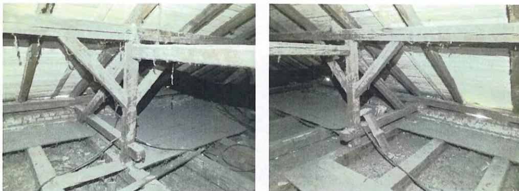
Foto nr. 33 a, b – Aspecte elemente – șarpantă
