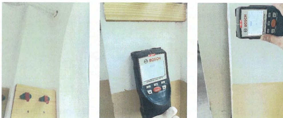
Foto nr. 48 a, b, c – Aspecte sondaje stâlp– consolidări
