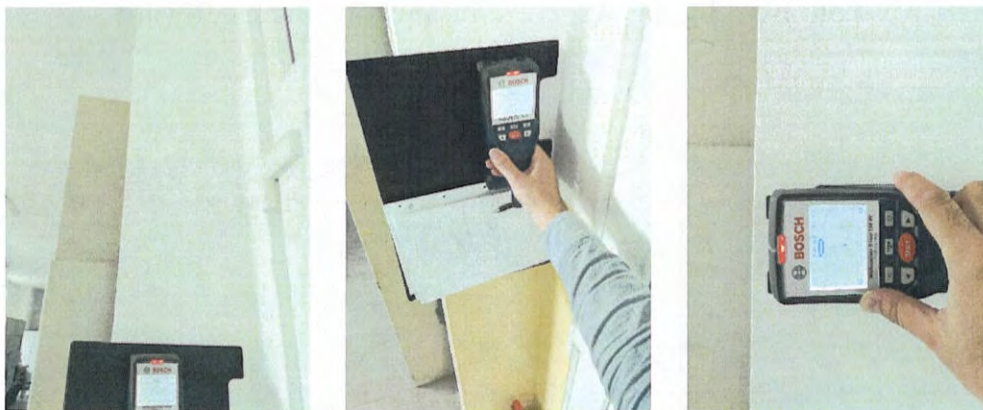
Foto nr. 47 a, b– Aspect sondaje stâlpi – consolidări
