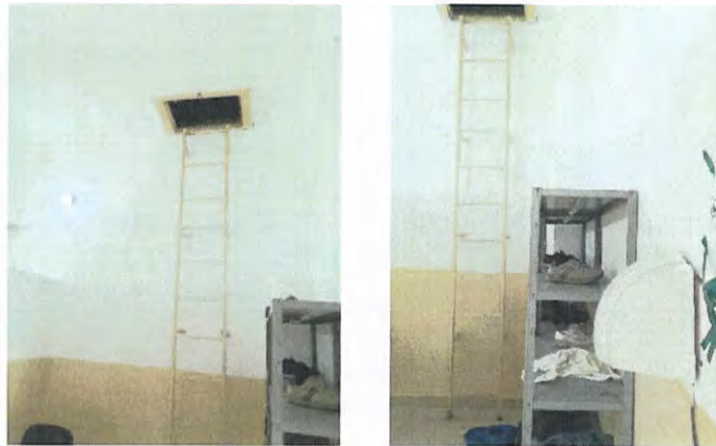
Foto nr. 31 a, b – Aspecte acces pod
