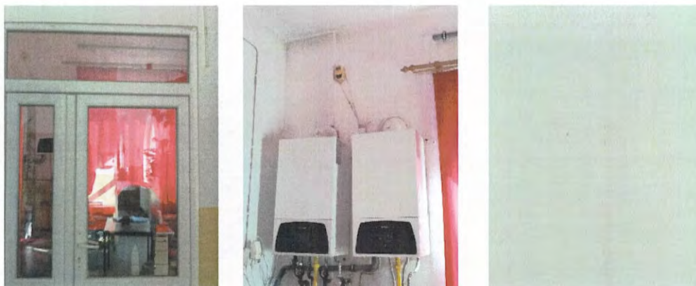
Foto nr. 30 a, b – Aspecte interioare – încăperi între axele A-B
