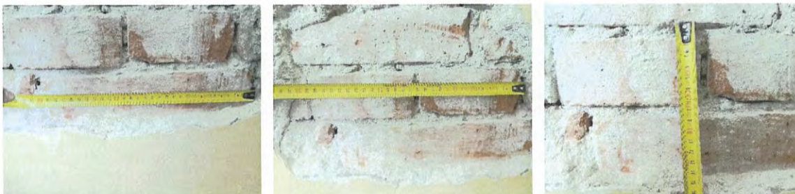
Foto nr. 51 a, b, c– Aspect dimensiuni elemente – perete din zidărie
