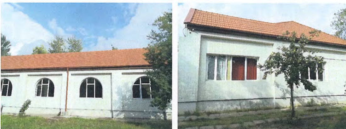
Foto nr. 2 a, b – Aspecte fațade vest / sud
