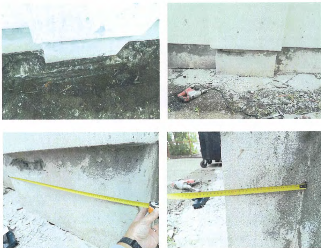
Foto nr. 40 a, b, c, d – Aspect sondaje consolidări elevații
