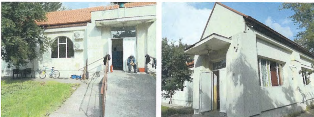
Foto nr. 1 a, b – Aspecte general clădire
