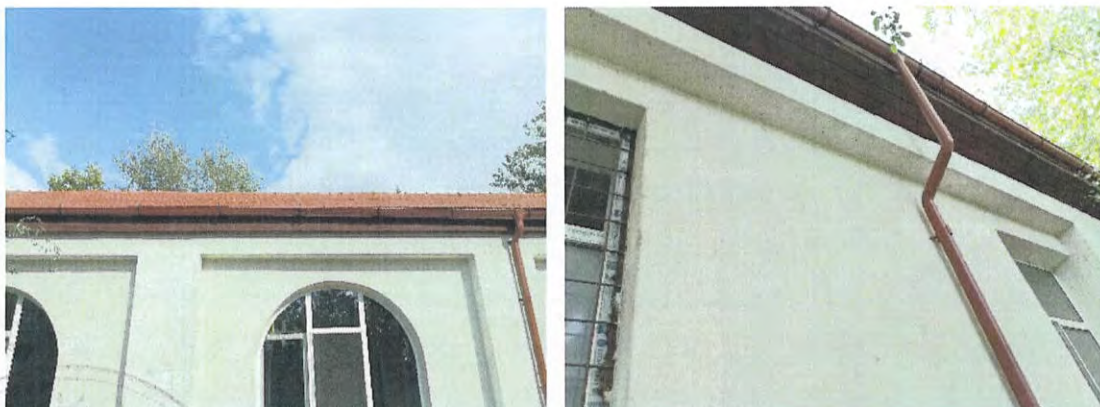
Foto nr. 6 a, b – Aspecte consolidări fațade
