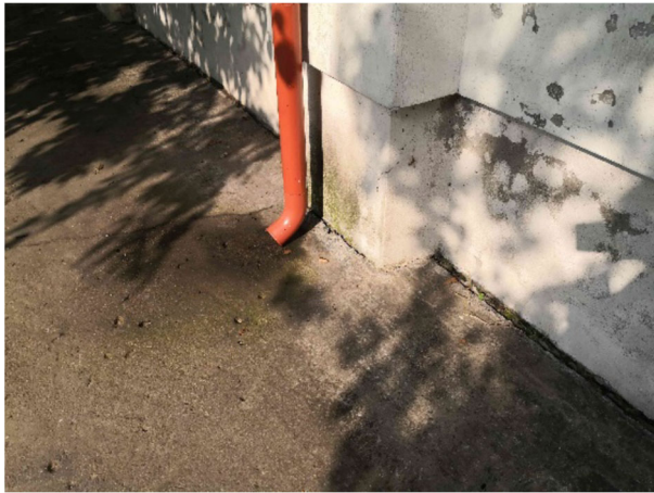
Tencuieli degradate la nivelul soclului și fațadei.
