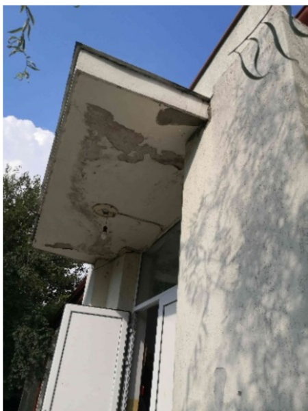
Aspect degradări și finisaje-copertină acces
