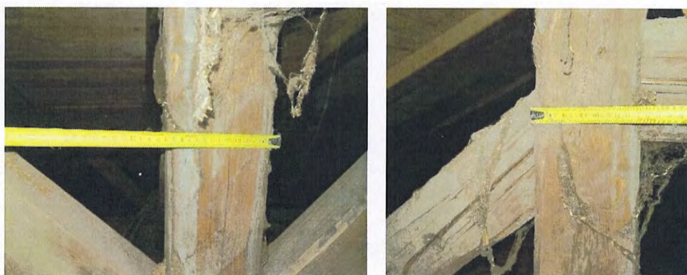
Foto nr. 55 a, b– Aspect sondaje elemente șarpantă – pop
