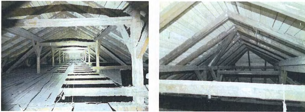
Foto nr. 32 a, b – Aspecte generale – șarpantă
