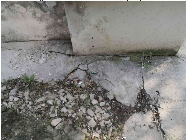
Degradări la nivelul trotuarului. Lipsa termoizolației în zona de soclu
