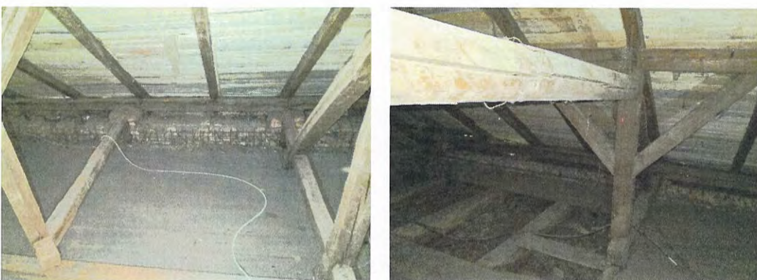
Foto nr. 39 a, b – Aspecte elemente – șarpantă
