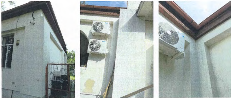
Foto nr. 5 a, b, c – Aspecte consolidări fațade
