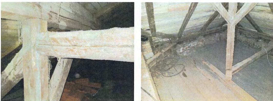
Foto nr. 38 a, b – Aspecte elemente – șarpantă
