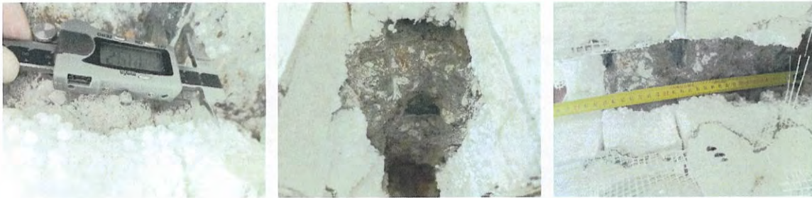
Foto nr. 45 a, b, c– Aspect sondaje centuri - consolidări
