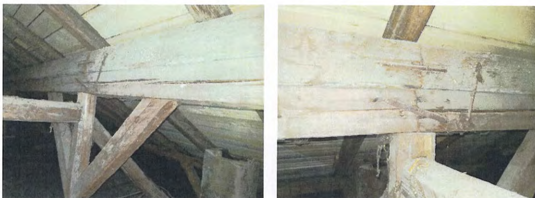
Foto nr. 37 a, b – Aspecte elemente – șarpantă
